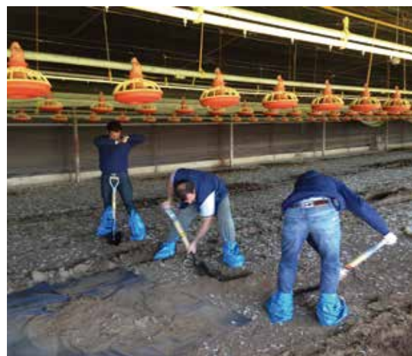
FOTO 2. Cavado de canaleta.
